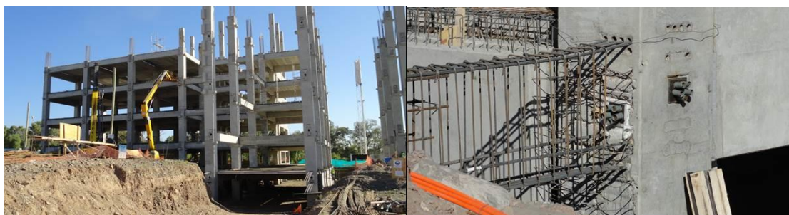
Figura 3. Sistema PRESSS utilizado en la construcción del edificio de 8 niveles del Polo Judicial de la Provincia de Mendoza. Abril de 2019
