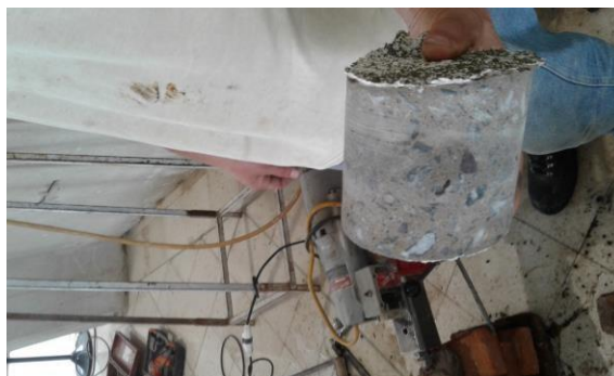
Figura 3: Testigo cilíndrico obtenido de la estructura.
