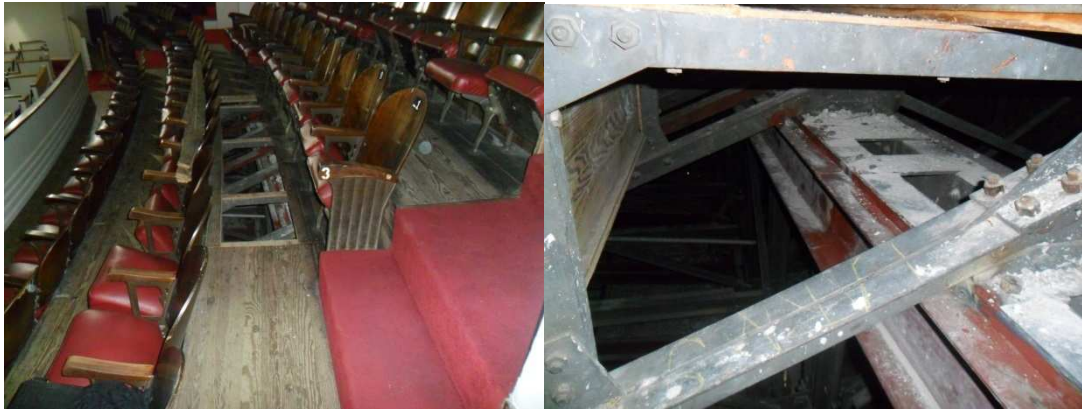
Figura 11. Viga transversal refuerzo ejecutado.
