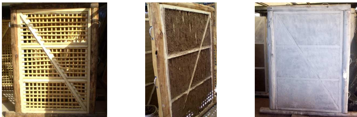
Fig. 1: Secuencia de armado del panel de quincha: Izq. Armado del bastidor y esqueleto de caña. Medio: Aplicación de barro. Der: Panel terminado.
