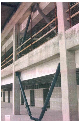
Figura 2: Estructura existente rehabilitada con BPR.
