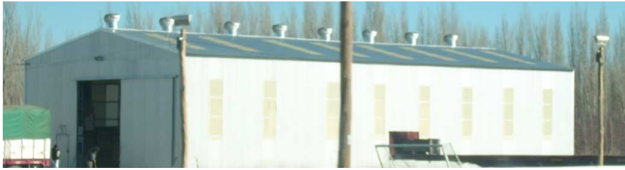
Figura 4: Galpón con techo a dos aguas y cerramiento de chapa sinusoidal, (Expreso Río Negro, Gral. Roca).
