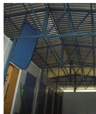
Figura 3: Galpón con techo a dos aguas de chapa trapezoidal y revestimiento lateral de chapa, (Tres Ases, Cipolletti), (a) Vista general, (b) Estructura resistente interior.
