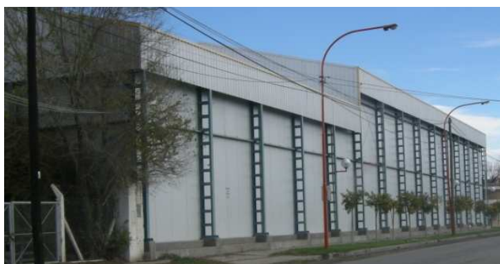
Figura 3: Galpón con techo a dos aguas de chapa trapezoidal y revestimiento lateral de chapa, (Tres Ases, Cipolletti), (a) Vista general, (b) Estructura resistente interior.
