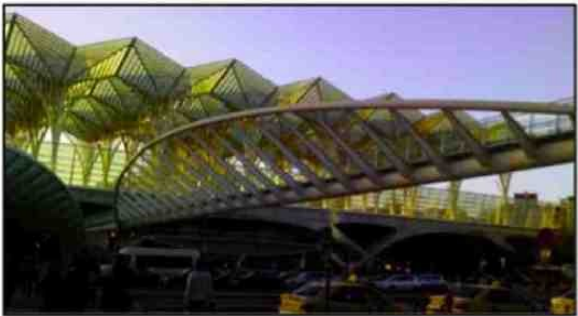
Figura 2: Gare do Oriente [Estação Ferroviária e Rodoviária do Oriente] -Lisboa - Portugal
