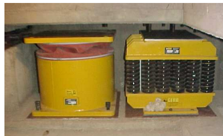
Figura 4. Dispositivos del sistema de aislamiento posicionado debajo del edificio.
