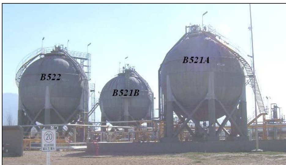
Figura 1 – Vista general de contenedores esféricos de LPG. Vista de riostras
