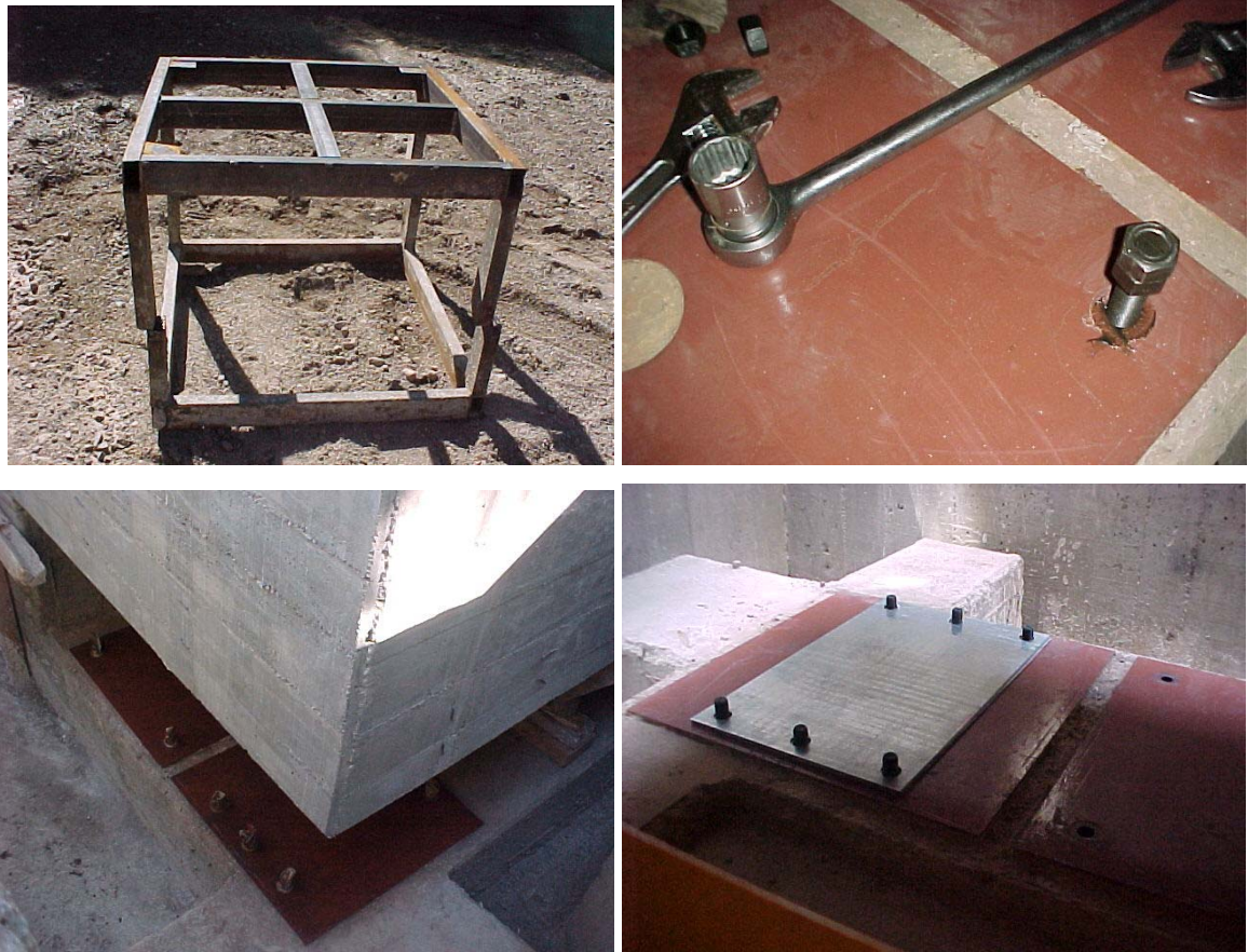
Fig. 9.21: Trabajos previo al montaje del sistema de aislamiento. Remoción de estructura metálica provisoria y limpieza de platinas y bulones de anclaje.
