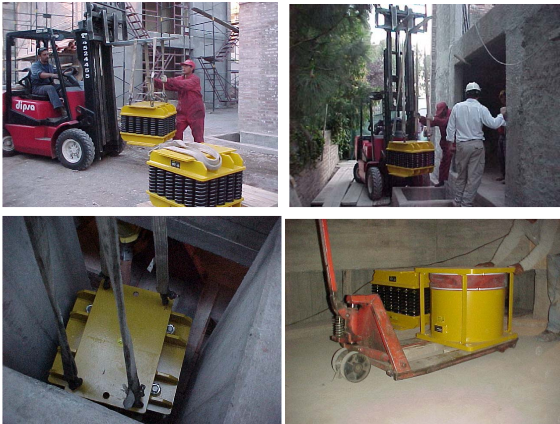
Fig. 9.22: Posicionamiento del sistema de aislamiento previo a proceder a levantar el edificio.
