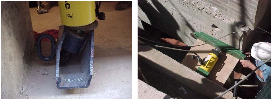
Fig. 9.25: Algunos factores que influyeron en las dos instancias de fracaso durante la instancia de levantar el edificio y montar el sistema de aislamiento sísmico
