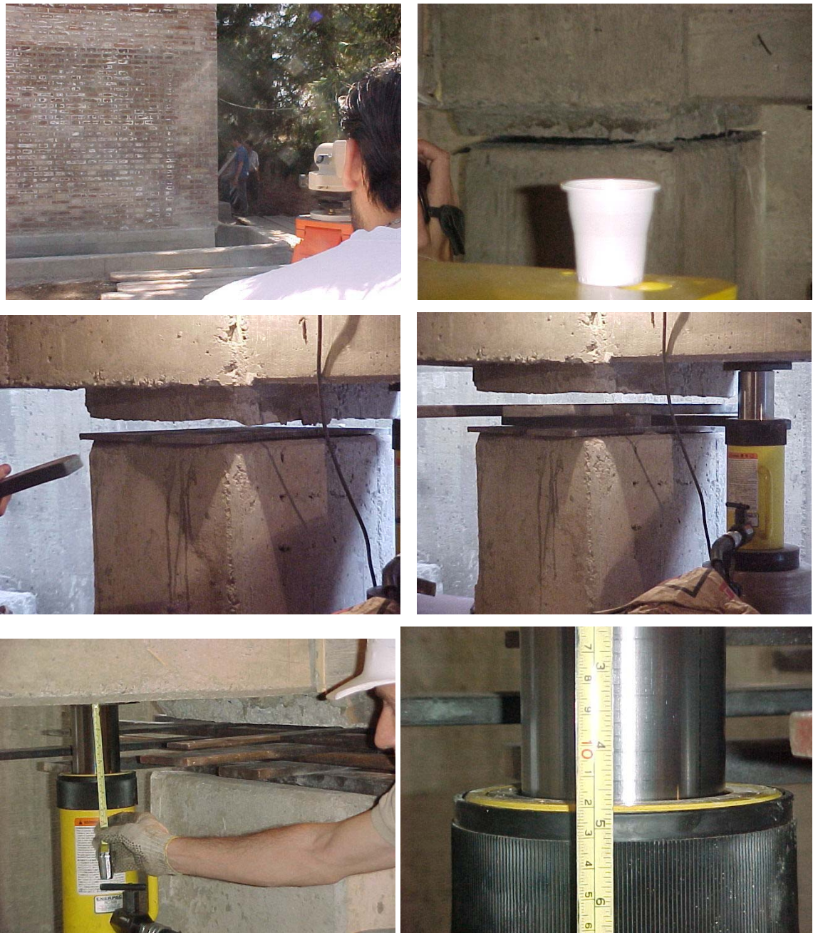
Fig. 9.24: Etapa de ascenso y control de la verticalidad del edificio.
