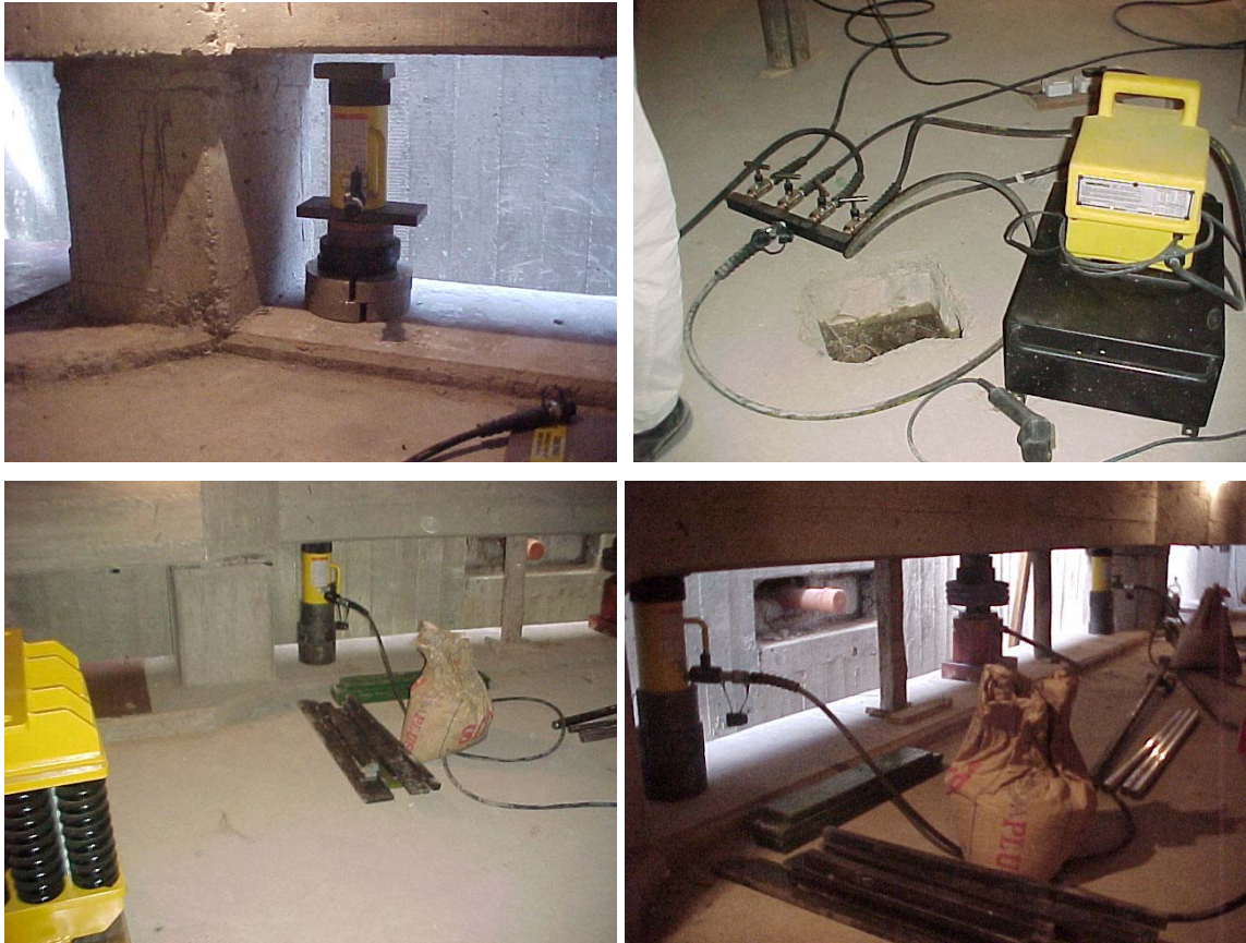
Fig. 9.23: Posicionamiento de los gatos durante el proceso de levantar el edificio para insertar el sistema de aislamiento GCS.
