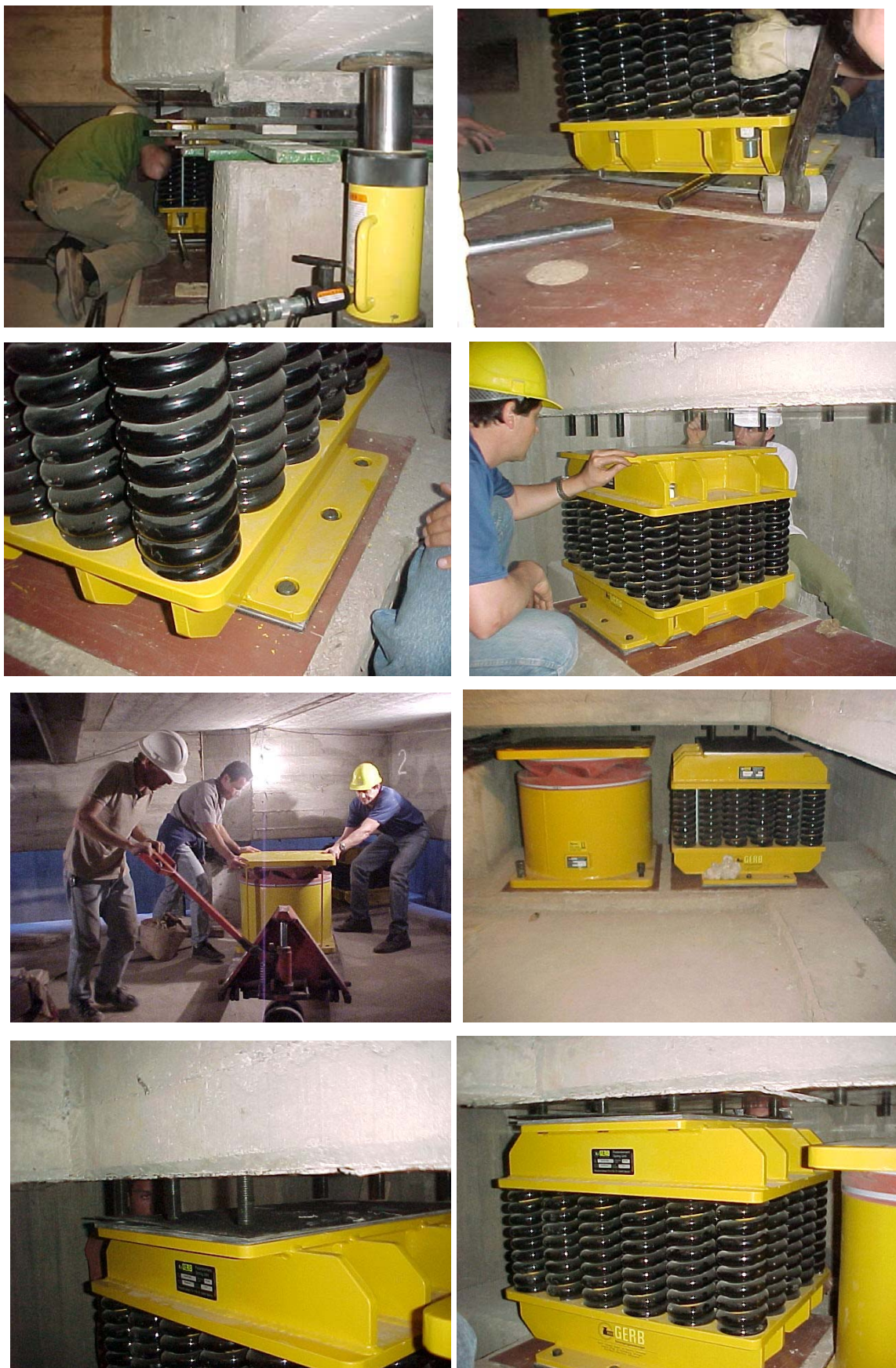
Fig. 9.26: Etapas de posicionamiento del sistema de aislamiento en su posición final y del descenso del edificio
