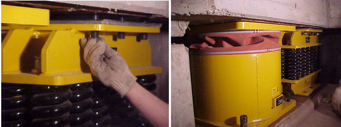
Fig. 9.26: Etapas de posicionamiento del sistema de aislamiento en su posición final y del descenso del edificio.
